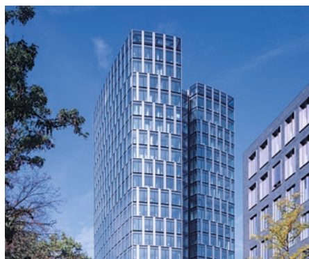
WestendDuo, Frankfurt/Main, Deutschland, Bürogebäude
