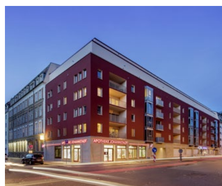
Dresden, Deutschland, Wohn- und Geschäftsgebäude
