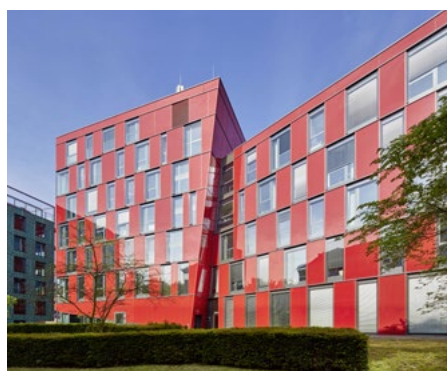
Dock 47, Hamburg, Deutschland, Bürogebäude
