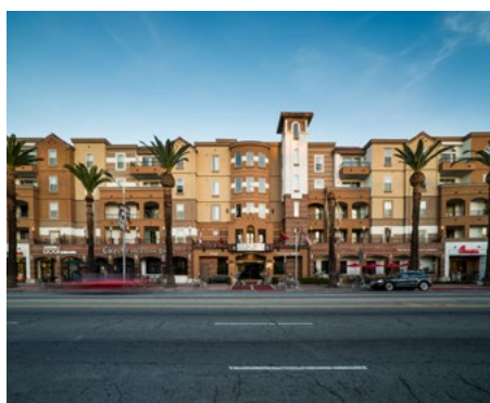
Tuscany Apartments, Los Angeles, Kalifornien/USA, Wohn- und Geschäftsgebäude
