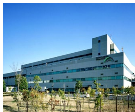
Narita, Chiba, Japan, Lager-, Logistikgebäude
